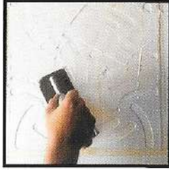
(3) تطبيق منتج كرافيك على البوشوار بواسطة طالوش إنوكس
