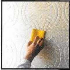
(6) حك بواسطة ورق زجاج 100 حتى الحصول على شكل سلس
